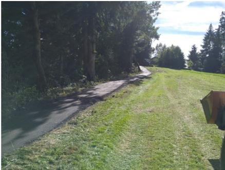
Am Höhenweg wurde vom Bauhof der Bereich mit den Wurzeln ausgebessert. Die Wurzeln sind nun unter einer Schicht Fräsasphalt und sind somit keine Gefahr mehr für eine Stolperfalle. Die Bäume und Sträucher wurden auch zurückgeschnitten.
